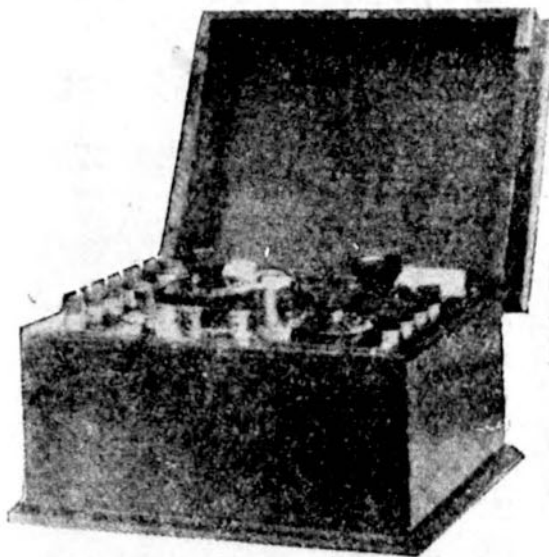
No.2 逓信省型式證明第25號 眞空管式受信機(一球)
